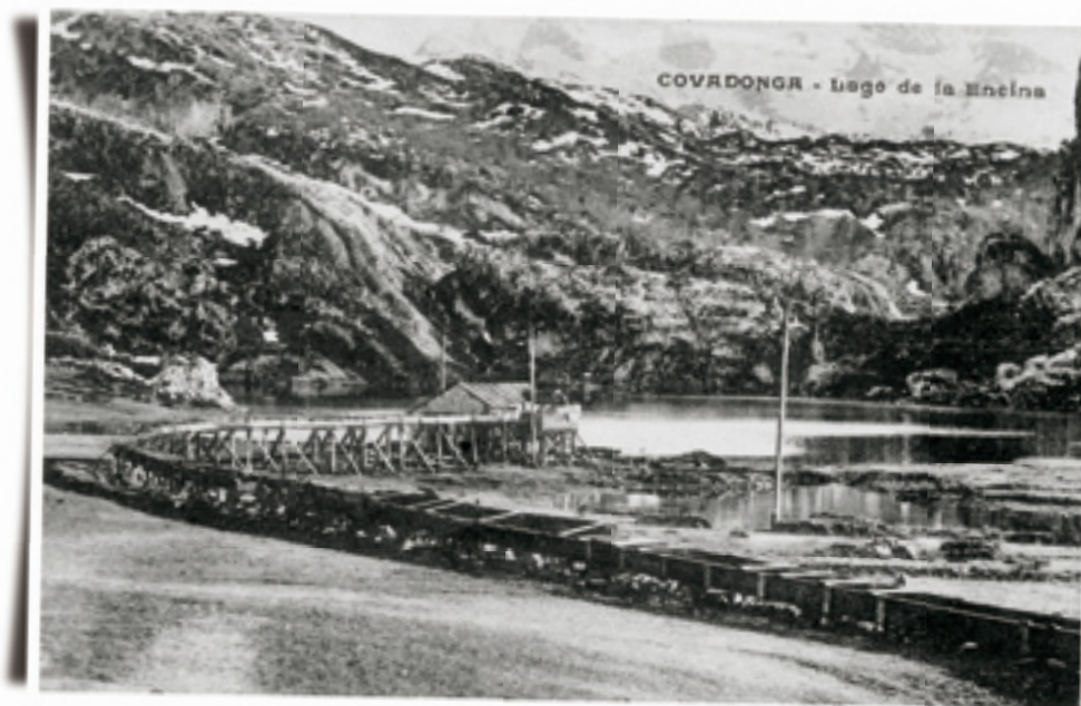
Estructura de captación y canalización del agua del lago de La Ercina. Utilizada para la producción de energía eléctrica y lavado de los minerales en las instalaciones de la compañía inglesa, The Asturiana Mines Limited , que explotaba el yacimiento de manganeso de Buferrera. Fotografía cedida por Asociación Cultural Abamia
