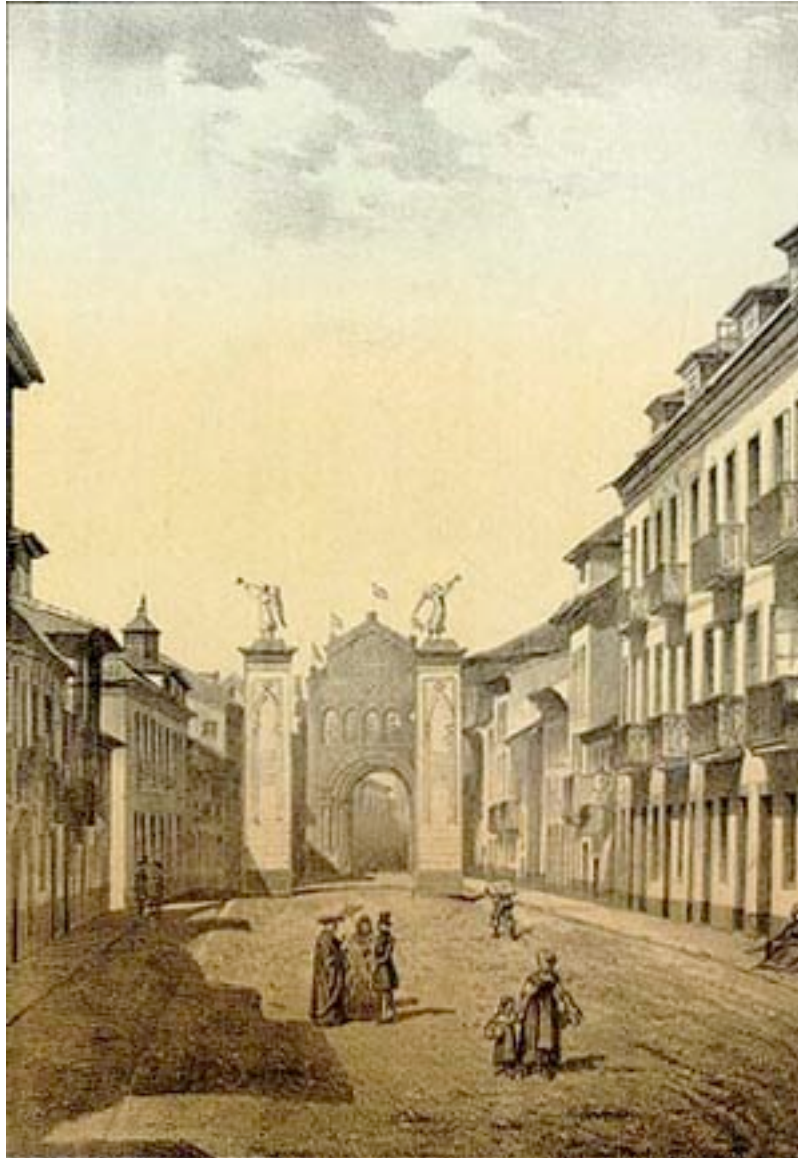
La calle Corrida, en Gijón. Grabado publicado en el Viaje de SS.MM. por Castilla, León, Asturias y Galicia verificado en el verano de 1858 , obra de Juan de Dios de la Rada y Delgado, Madrid, 1860.
